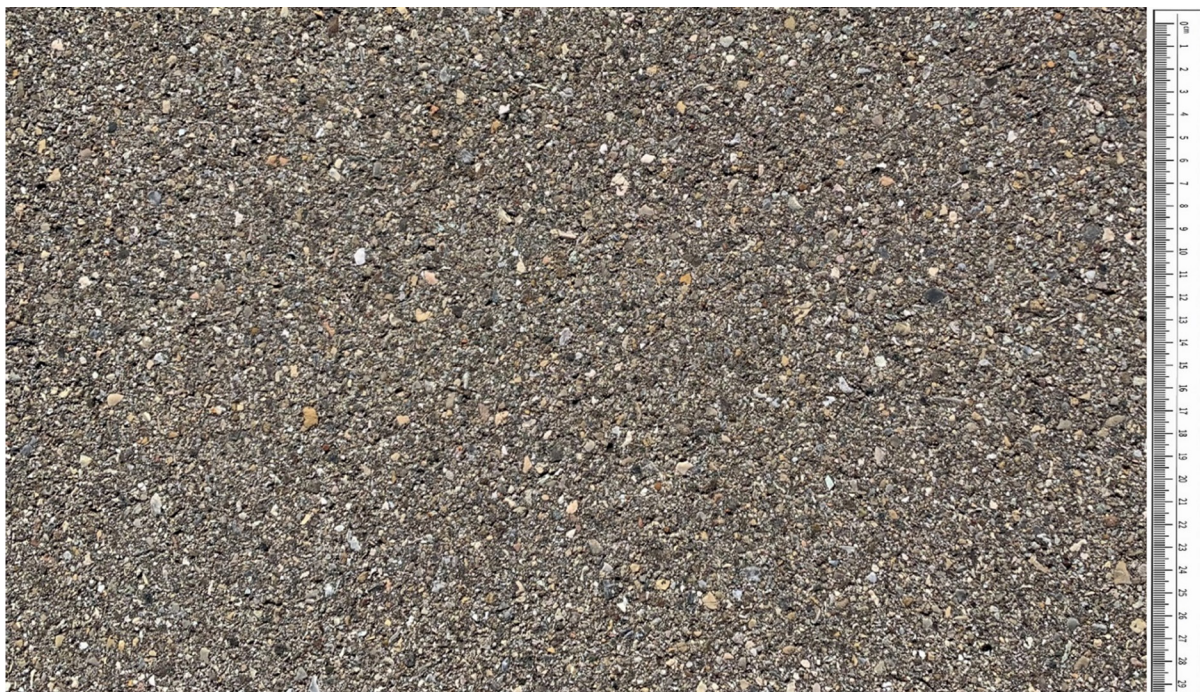
Abbildung 1: Glatte Asphaltoberfläche der 900 m langen Versuchsstrecke (© J. Schwehn)
