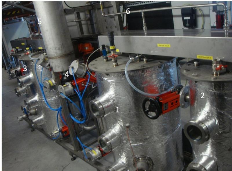
Abbildung 2: Teilansicht der Pilotanlage am Aufstellungsort am Deutschen Biomasseforschungszentrum gemeinnützige GmbH Leipzig (DBFZ) 1 Hauptfermenter 2, HFB; 2 Nachgärer 2; 3 Hauptfermenter 1, HFD; 4 pneumatisch betriebene Schieber V-5 / V-6; 5 Vorlagebehälter; 6 Biogasleitung (© U. Pliquet)
