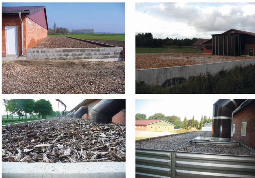
Abbildung 1: Einstufige Biofilteranlagen zur Beseitigung von Gerüchen aus Tierställen (© J. Hahne)
