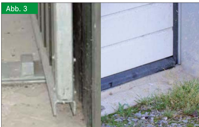
Links seitlicher Anschluss bei einem Schiebetor, rechts dichtschießender Toranschluss bei einem Sektionaltor. Fotos: vTI Fig. 3: Left lateral connection of a sliding door, right tight fitting sectional door
