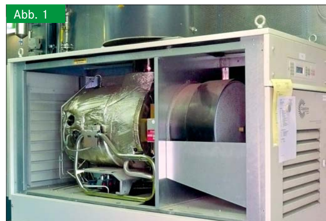
Mikrogasturbine Capstone CR 65. Foto: Bekker Fig. 1: Mikrogasturbine Capstone CR 65
