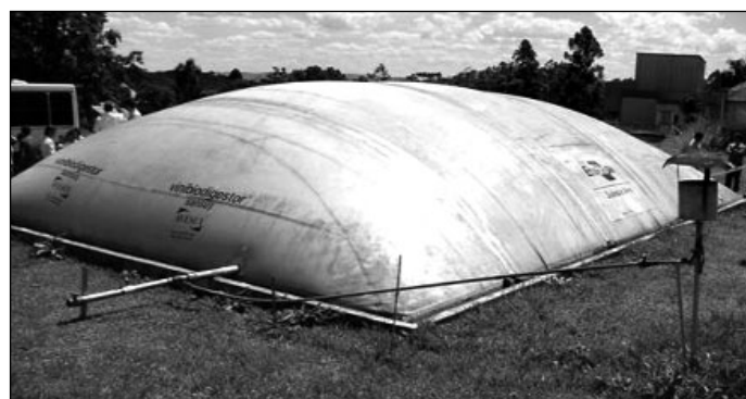
Bild 2: Biogasanlage der Embrapa in Concórdia-SC
