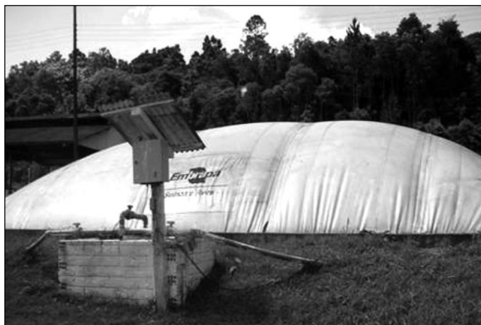
Bild 3: Biogasanlage mit solarbetriebener Pumpe zur Zirkulation des Substrates
