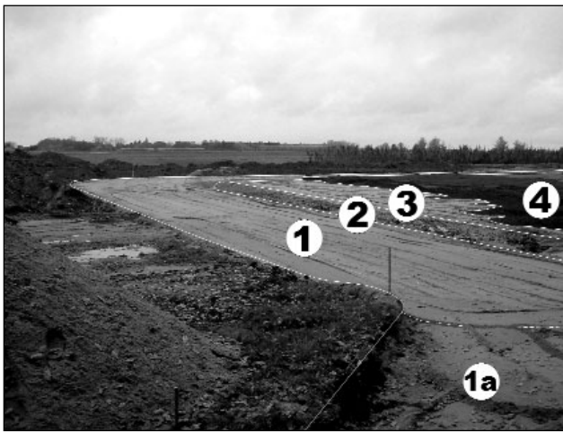
Bild 2: Grundbau eines Fahrtilos
