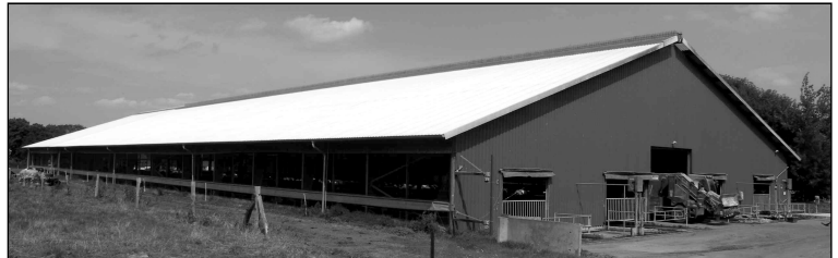
Bild 1: Außenansicht des Stalles aus südlicher Richtung
