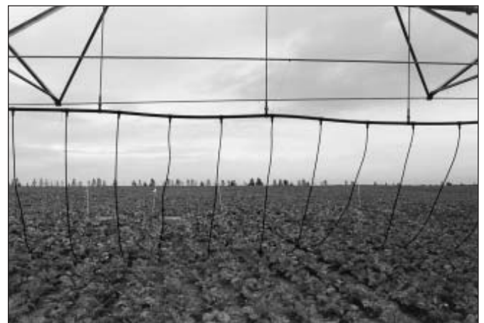
Bild 1: Aufbau einer mobilen Tropfbewässerung an einer Kreisberegnungsmaschine
