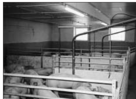
Bild 1: Zuluftführung über Rieselkanäle
