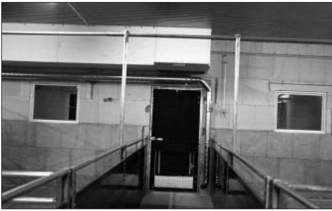
Bild 2: Zuluffführung über Futtergang
