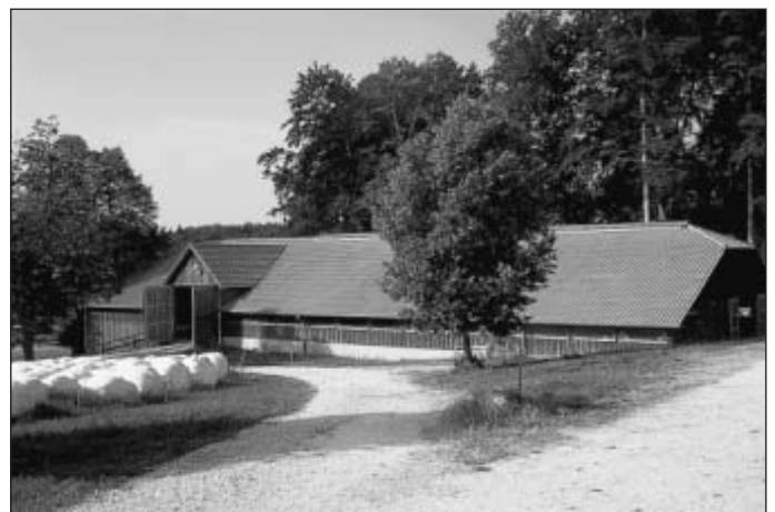
Bild 1: Landschaftstypischer Schafstall mit Krüppelwalmdach und stehenden Gauben
