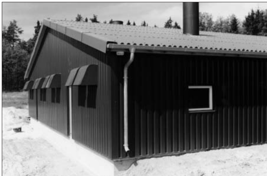
Bild 2: An diesem Schweinemaststall wurde als Vorsatzschale Trapezblech eingesetzt. (Quelle: Firma Laukien, Kiel)
