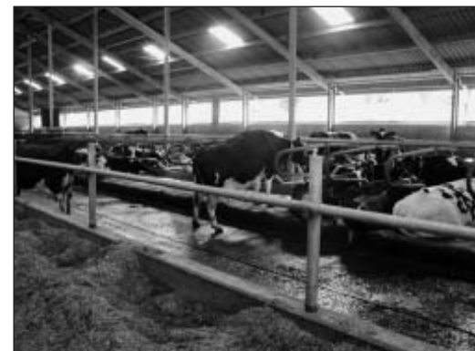
Bild 1: Moderner Außenklimastall mit Trauf-First- und Querlüftung, Entmistung mit automatischen Schiebersystem, Fütterung als TMR
