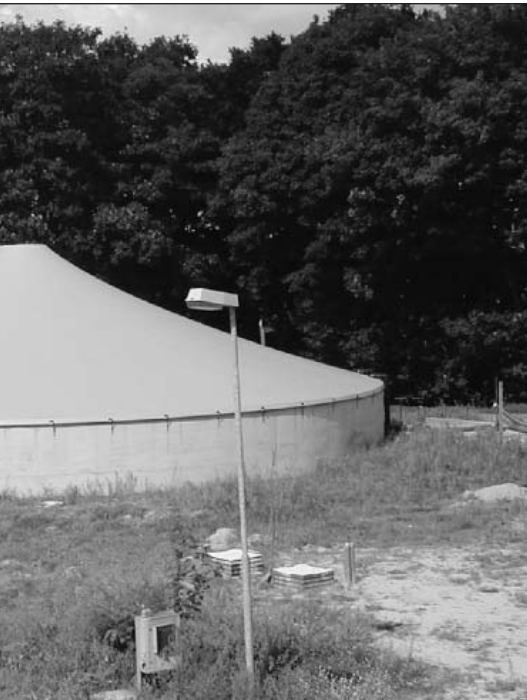
Bild 1: Güllebehälter aus Stahlbeton mit Abdeckung als „Zeltdach“
