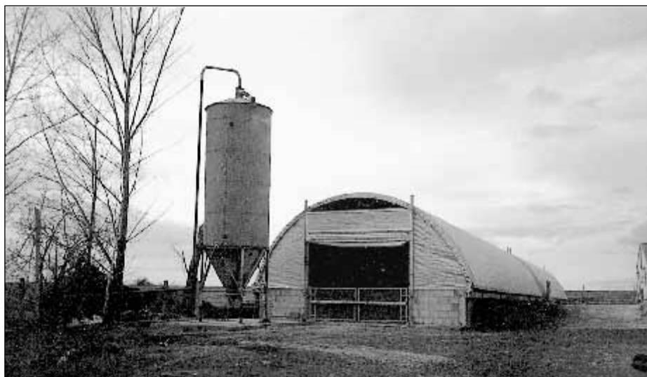
Bild 2: Ansicht des Folientunnelstalles (Foto: Koch)
