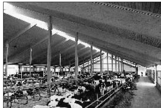
Bild 2: Außenliegende Futtertische wie hier auf dem Betrieb Gaidetzka ermöglichen auch bei großen Beständen eine kompakte Bauweise
