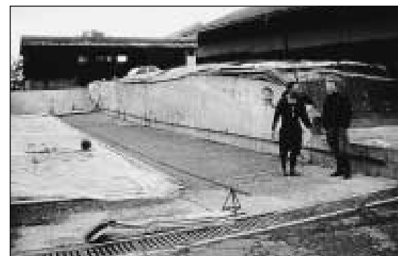
Bild 2: Nachbehandlung des Betons durch Abdecken
