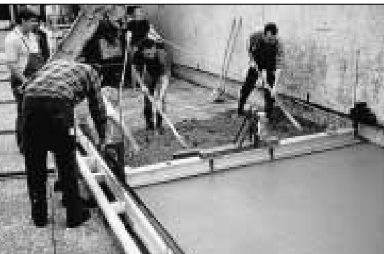
Bild 1: Betoniervorgang auf dem Meiereihof
