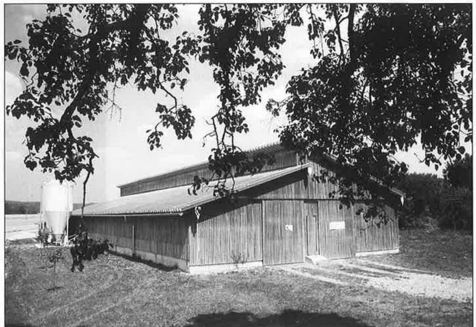
Bild 1: Funktional und ansprechend gestalteter Außenklimastall mit 320 Mastplätzen und Holzverschalung als ganzflächige Schlitzwandlüftung (Stall Hafner, Foto Achilles)
