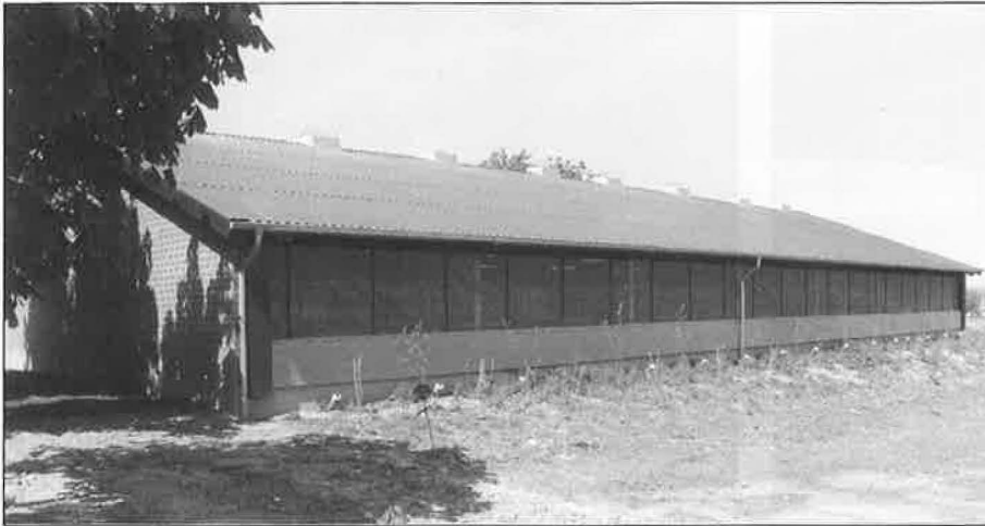
Bild 2: Außenklimastall für 320 Mastschweine mit temperatur- und windgesteuerten Jalousien vor den Lochfolien (Stall Schulze Entrup, Foto Fritzsche)
