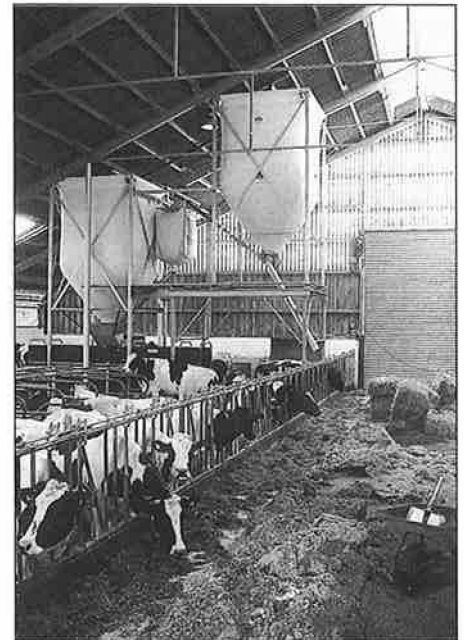
Bild 2: Typischer Außenklimastall mit Space-Board-Zuluftöffnungen an den Traufen und im Giebel. Das Futter in den Blöcken ist teilweise gefroren. Größere gefrorene Futterstücke werden manuell aussortiert
